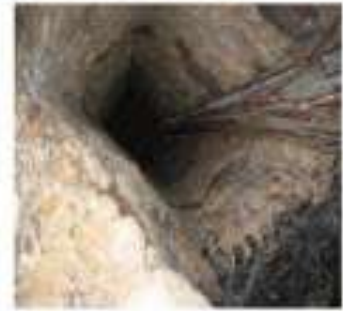
Monte charge pour les munitions des 95mm et 240mm. Transformé en issues de secours, et conduits pour les câbles des transmissions en 1943/45
