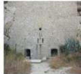
Monte charge pour les munitions des 95mm et 240mm. Transformé en issues de secours, et conduits pour les câbles des transmissions en 1943/45
